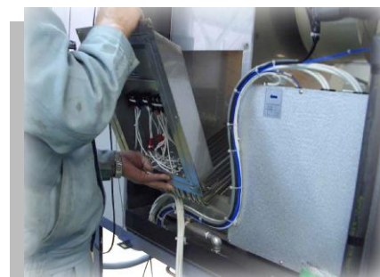
加湿器ヒーターエレメント部分の取り外しが容易でメンテナンス性向上。
